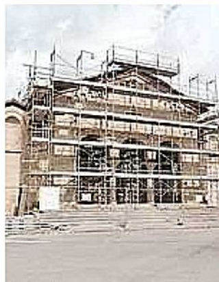
SAN CASSIANO Le impalcature che ricoprono la facciata
